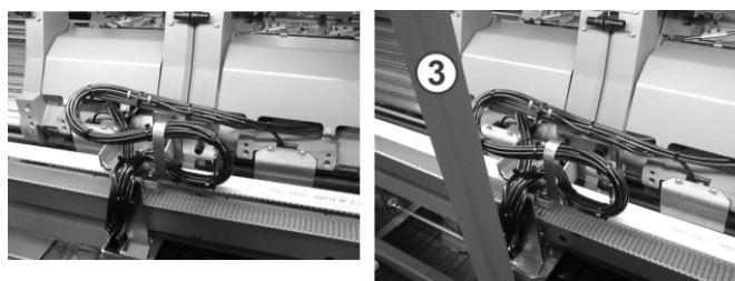
Colocar el tramo de cables en el soporte
