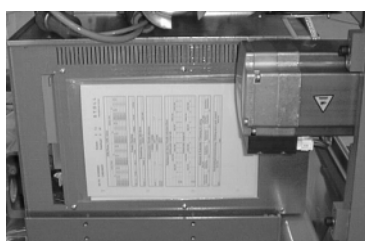
Feuille de données de la machine dans l'armoire de commande droite
