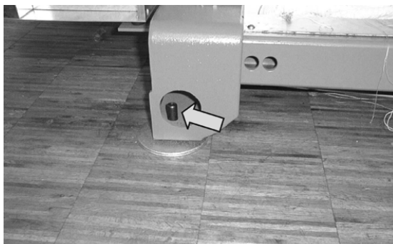
Tiges filetées servant à aligner la machine
